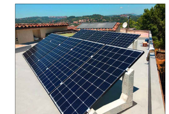
Tipico installativo, struttura a 30°, su tetto piano
