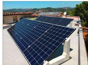
Tipico installativo, struttura a 30°, su tetto piano
