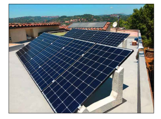
Tipico installativo, struttura a 30°, su tetto piano
