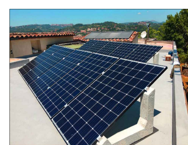
Tipico installativo, struttura a 30°, su tetto piano
